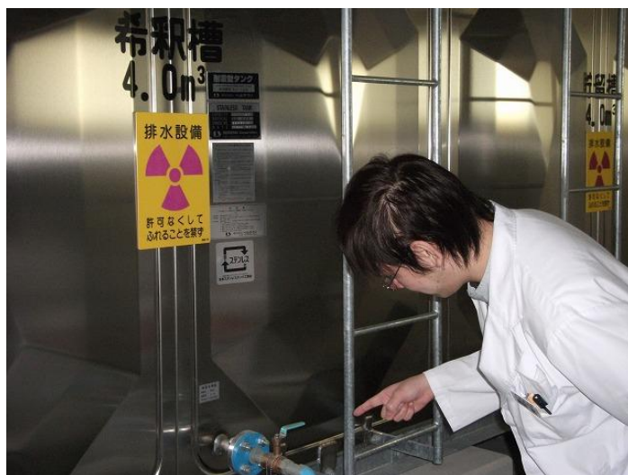
受講後、排水設備の点検をしている筆者
